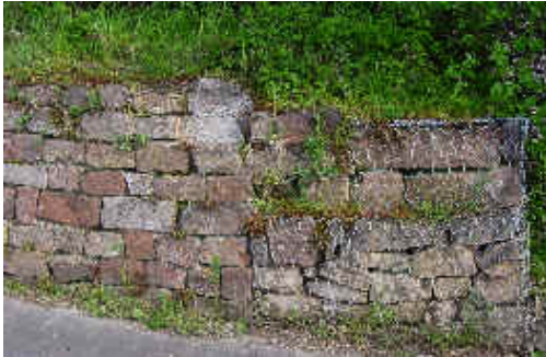
Abb. (32) Trockenmauern als Stützmauern
